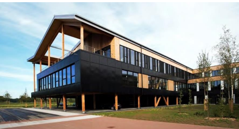
Le Grand Carré, Villeneuve d'Ascq (59)
